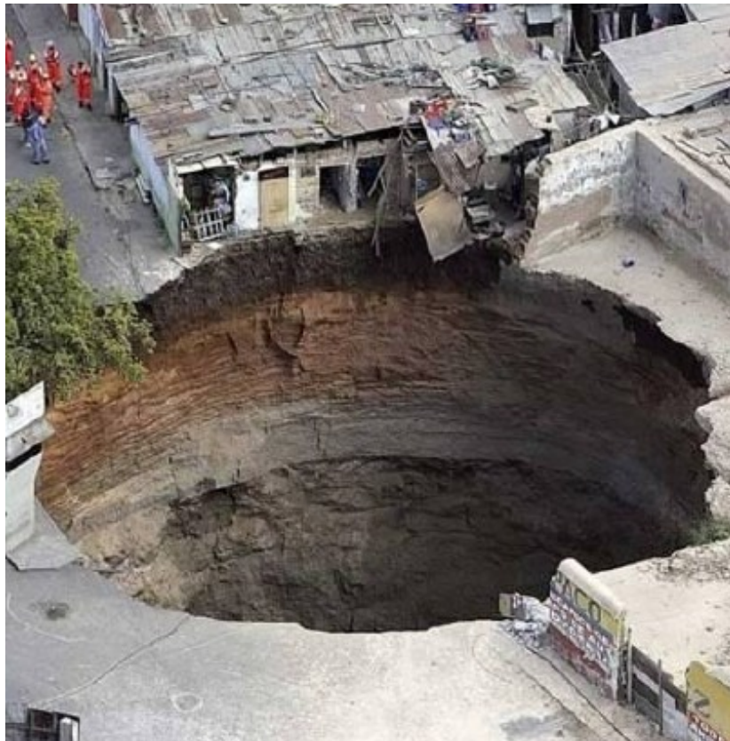
Sinkhole in gessi nella città di Grasse (Dipartim. Var – Regione PACA)
