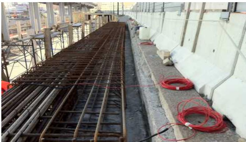
*montaggio barrette estensimetriche nell'armatura del portale del varco Levante*
