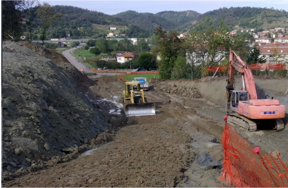
Scavi trincea e raccordo con lotto esistente lato Pallare
