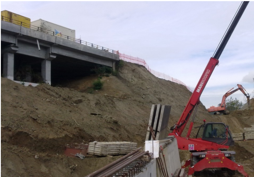
Scavi trincea lato Savona e interferenza con Autostrada A6 TO-SV
